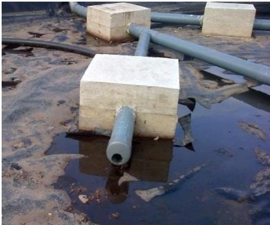
Las lagunas se diseñan con un sistema de tuberías para la evacuación de lodos.
