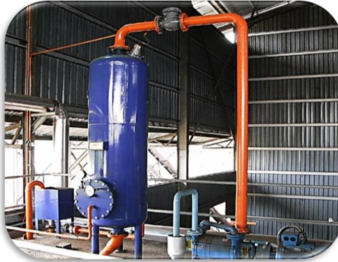
Sistemas de secado al vacío
